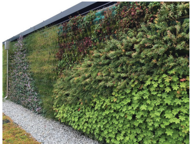
Illustrasjon 28. En av få norske grønne vegger basert på et moduldyrkings-system. Bossnetterminalen i Jekteviken i Bergen. (Foto: Wikholm AS)
